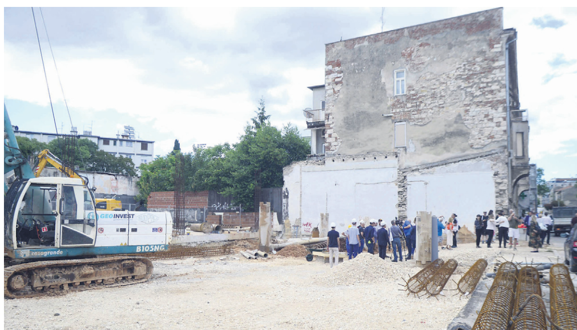
Uklonjena stara zgrada Mehanike, započele pripreme za temelje nove zgrade Coworking centra
